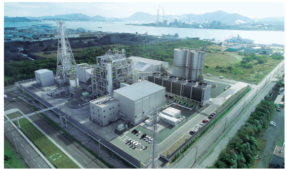
響灘火力発電所
