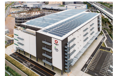
太陽光パネルを設置した物流施設「DPL三郷Ⅱ」
