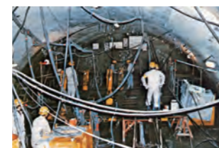
上越新幹線中山トンネル工事の注入作業
