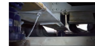
支承とジャッキ
