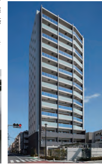
武蔵関マンション
