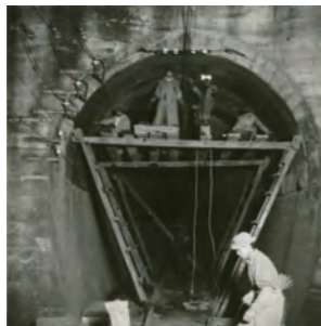
トンネル防水工事
