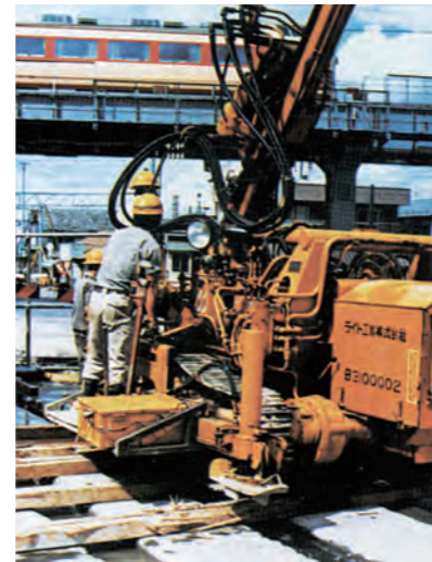
ソレタンシュ工法が実施された青森操車場構内旭町踏切立体化工事
