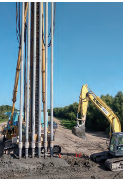
米国 ミシシッピ川西岸堤防改修補強工事(地盤改良)
