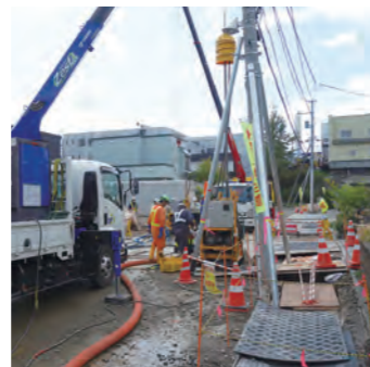
Megaジェット工法を用いて流動化を防止
