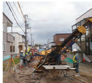
浸透固化処理工法で住宅下部の地盤改良
