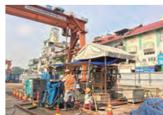
ベトナム ホーチミン市都市鉄道1号線CP1A(地盤改良)
