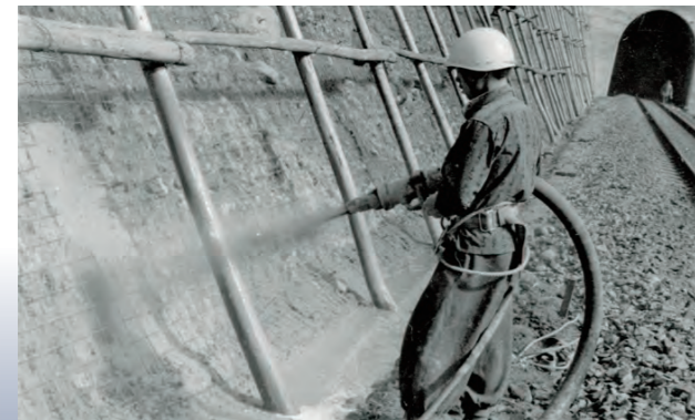
道路災害防除工事
