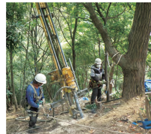
ロックボルト打ち込みの様子
