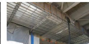
支取代替作業足場
