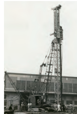
地盤改良工法であるRGパイル工法
