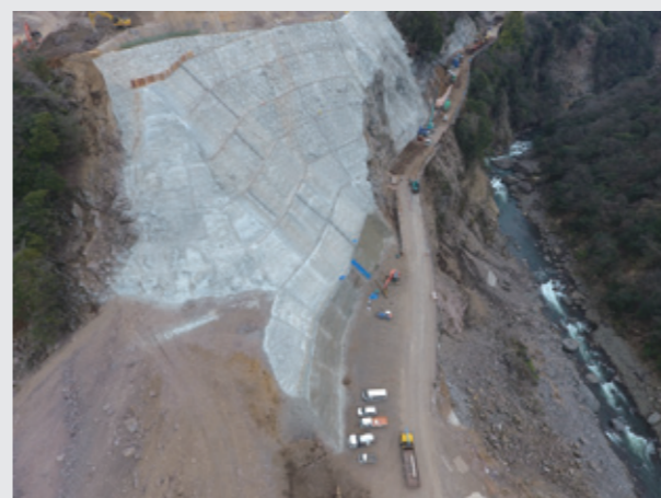
ライト工業は斜面崩壊した阿蘇長陽大橋と戸下大橋（写真）のり面を含む「長陽大橋ルート」の復旧工事を担った
