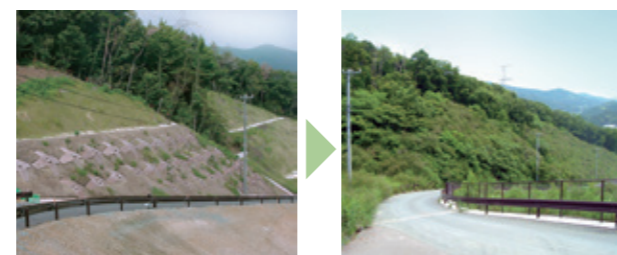
施工から3カ月後 施工から6年後
