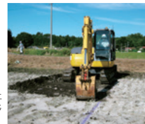
白色系固化剤の吹付けには、表土の取りこぼし防止や作業時の粉じん防止といった効果があります。
