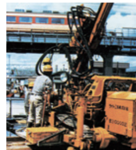
ソレタンシュ工法が実施された青森探検場構内旭町踏切立体化工事
