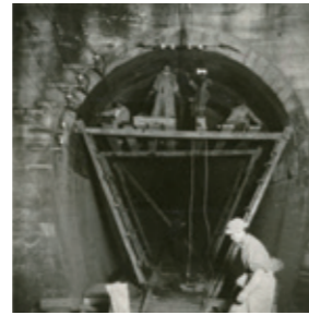
トンネル防水工事
