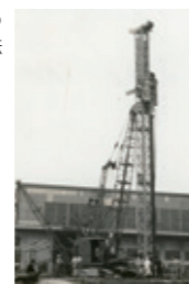
地盤改良工法であるRGパイル工法 道路災害防除工事
