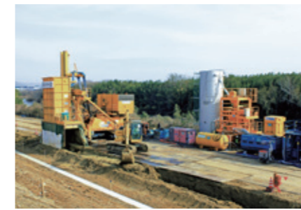
環境配慮型工法のECウォール工法
