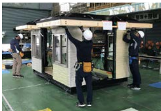
躯体外装コース 修了試験風景
