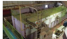
乾燥炉扉の外張り断熱
