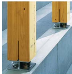
基礎ダイレクトジョイント
