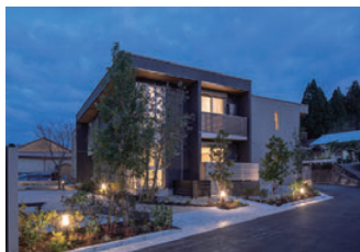
熊本県山都町 定住促進住宅外観
