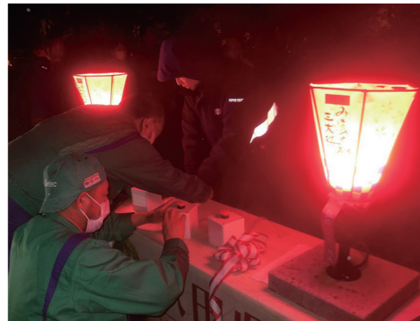
桜のライトアップの照明設置
