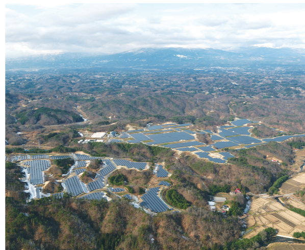
二本松太陽光発電所(福島県)
