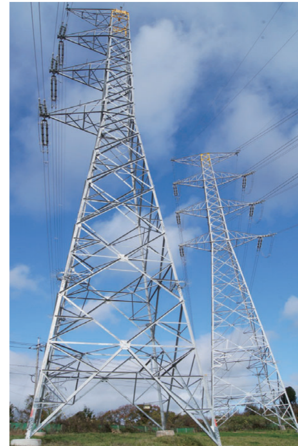
電力輸送の動脈である架空送電線の新増設工事、点検保守工事を一貫して行い、電力の安定供給を担っています。
