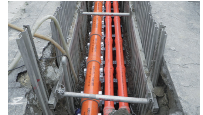
安定した電力を大量に必要とする都市や工場への電力供給を担う地中送電線の新増設工事、保守点検工事を行っています。
