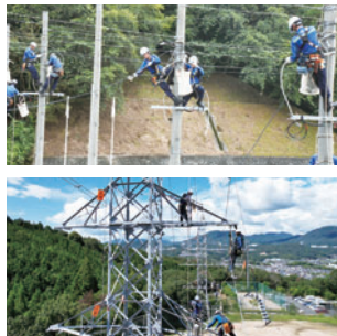
新入社員配電線・送变电教育
