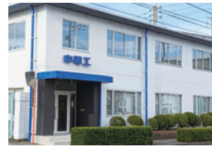
下関営業所 竣工：2024年1月(一期工事) 基準：『ZEB』 延床面積：778.68m 2 (地上2階)
