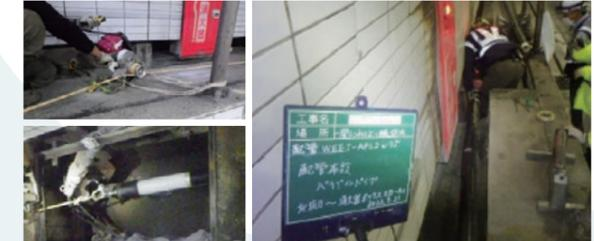
積雪量の多い東北地方では、融雪剤による腐食などの影響で、消火設備の劣化が大きな課題になっています。本工事では、トンネル内に設置された送水管を更新するにあたり、小口径のポリエチレン管にワイヤーを取り付けた後、ウィンチで巻き上げ、既設管内に引き込む「パイプインパイプ工法」を採用しました。
