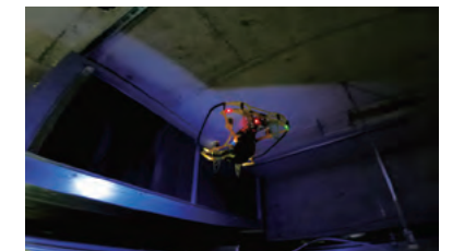
ドローン飛行による撮影状況(オフィス天井内)
