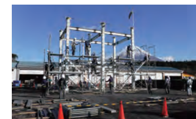
富士教育訓練センターでの足場組立実習
