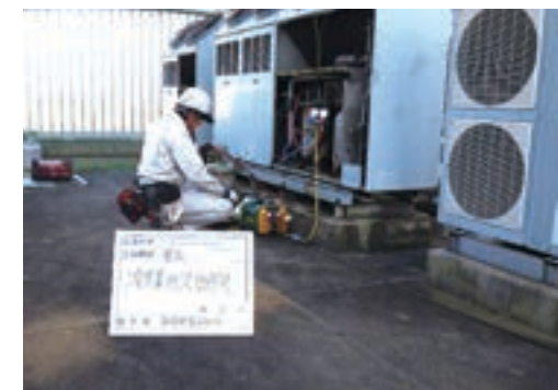
冷媒ガス回収作業
