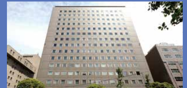
中国電力本社ビル (広島県)
