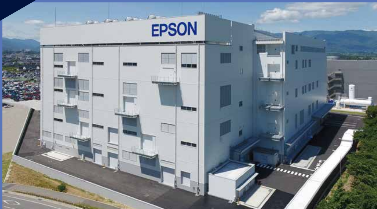
セイコーエプソン広丘事業所9号館 (長野県) 規 模 S造 地上5階 地下1階 延床面積 46,915㎡ 工事内容 ユーティリティ設備 竣工年月 2018年6月
