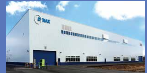
ダイナックス苫小牧工場 (北海道) 規 模 S造 地上2階 延床面積 工場拡張部 : 4,970㎡ 物流・コイルセンター : 11,365㎡ 工事内容 空調・衛生・消火・ユーティリティ設備 竣工年月 2018年4月 (工業用水・工業排水・圧縮空気・生産蒸気)
