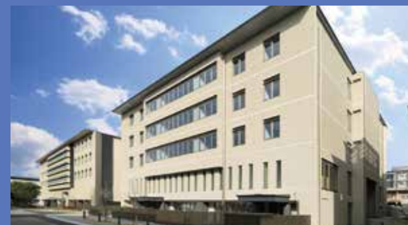
京都大学(南部) iPS細胞研究所第3研究棟 (京都市) 規 模 RC造 地上5階 地下2階 延床面積 約7,680㎡ 工事内容 空調・衛生・消火 竣工年月 2017年2月
