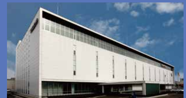
会津オリンパス(A棟) (福島県) 規 模 S造(免震構造) 地上5階 延床面積 54,321㎡ 工事内容 空調・衛生・消火 竣工年月 2009年3月
