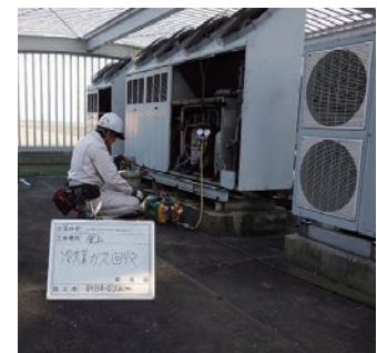
冷媒ガス回収作業
