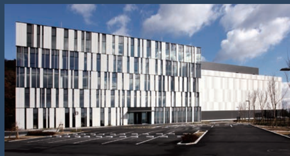
野村総合研究所 大阪第二データセンター (大阪府)
