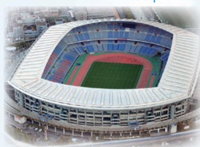
横浜国際総合競技場 (日産スタジアム)
