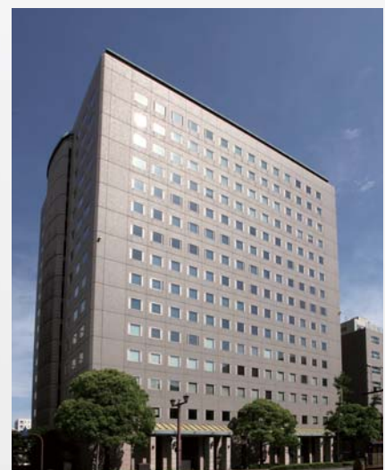
中国電力株式会社 本社ビル
