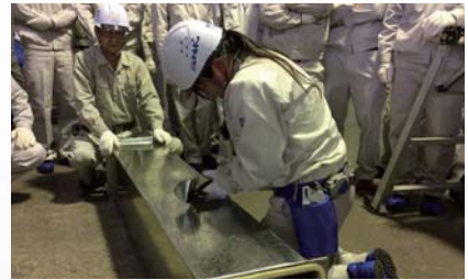
手作業によるダクト加工
