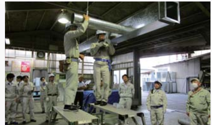
ダクト吊り込み体験
