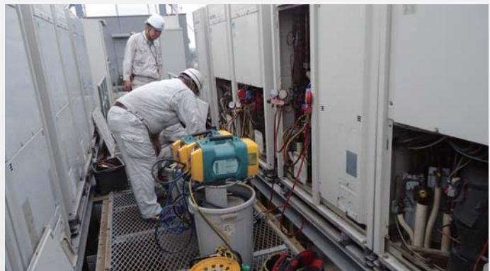
フロン類の回収作業
