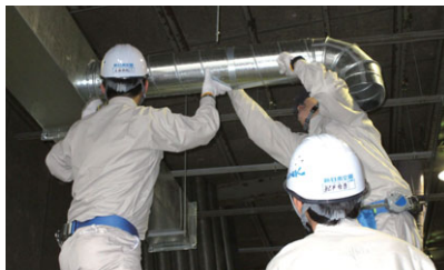
ダクト吊り込み体験(丸ダクト)
