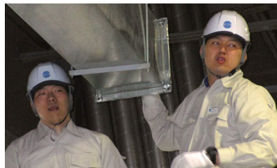
ダクト吊り込み体験(角ダクト)
