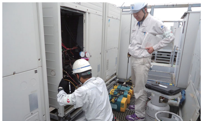
フロン類の回収作業
