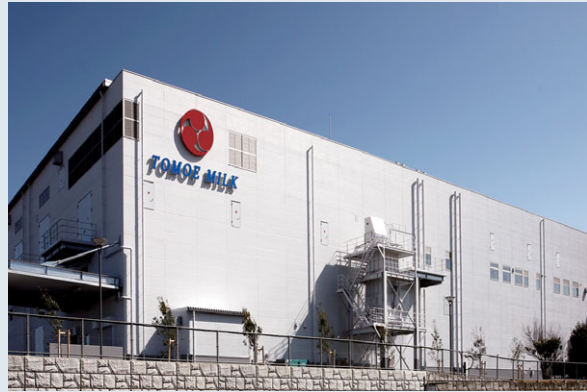
トモエ乳業第二工場 (茨城県)
