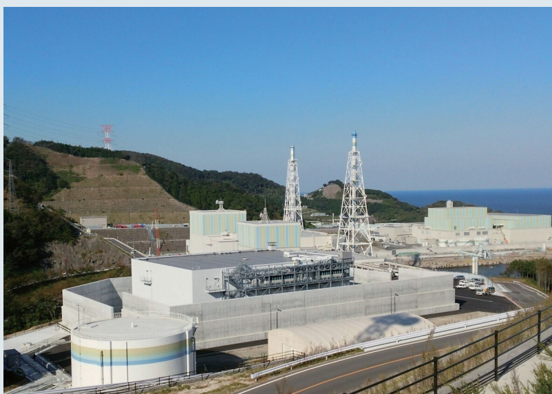
中国電力(株)島根原子力発電所 免震重要棟(島根県)
