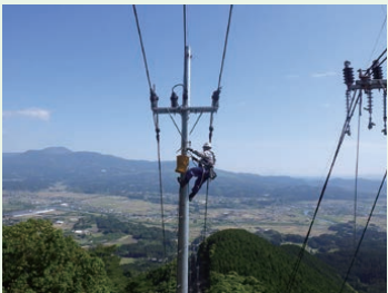
連系自営線工事
