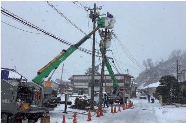
令和6年能登半島地震における災害復旧工事
