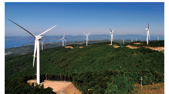
串間風力発電所
