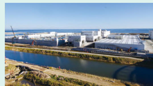
南蒲生浄化センター
