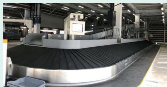
成田国際空港第1ターミナル南棟
