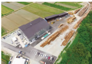
木質バイオマスガス化発電設備
