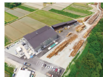
木質バイオマスガス化発電設備
