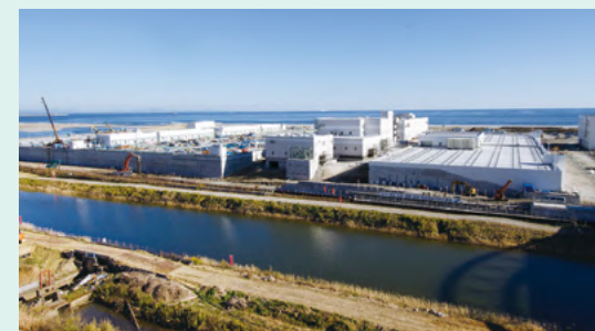
南蒲生浄化センター
