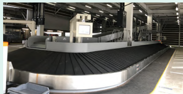
成田国際空港第1ターミナル南棟
