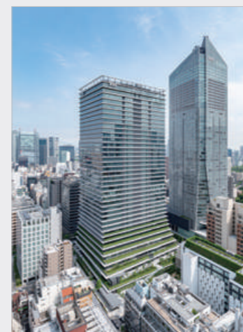
虎ノ門ヒルズ ビジネスタワー外観
