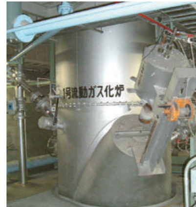
対馬クリーンセンター 基幹的設備改良工事
