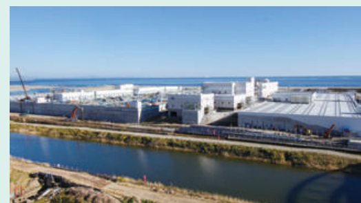
南蒲生浄化センター
