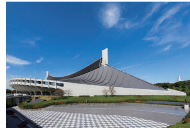
国立代々木競技場第一体育館 (写真提供：独立行政法人日本スポーツ振興センター)
