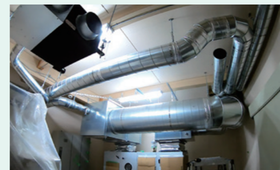
基本観測棟機械室の空調機廻りの施工状況の様子
