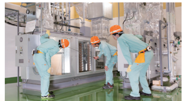
実機を活用した技術・技能研修
