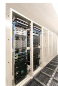
サーバールーム内は電子機器に悪影響を及ぼすウィスカ®対策を行いました。電話・LANを共通とした統合配線方式を採用し、無線LAN環境を構築することで、安定したネットワーク環境を整備しています。災害時に停電しても使用できる停電時対応型電話機も備えています。
