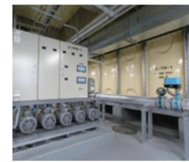
受水槽機械室にて、各棟に上水・雑用水を給水しています。雑用水はA・C棟で貯蔵された雨水をB棟でろ過した後、給水されます。地震発生時、受水槽が自動的にバルブを遮断し、配管破損による漏水を防ぎ、90トンもの飲み水の確保が可能です。
