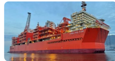
洋上LNGプラント(アフリカ)
