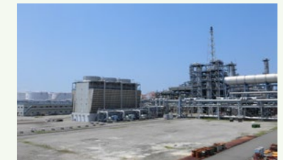
国産SAF製造設備の建設予定地（コスモ石油堺製油所）
