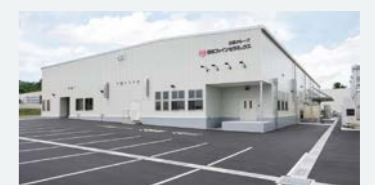
新設された高熱伝導窒化ケイ素基板の生産工場
