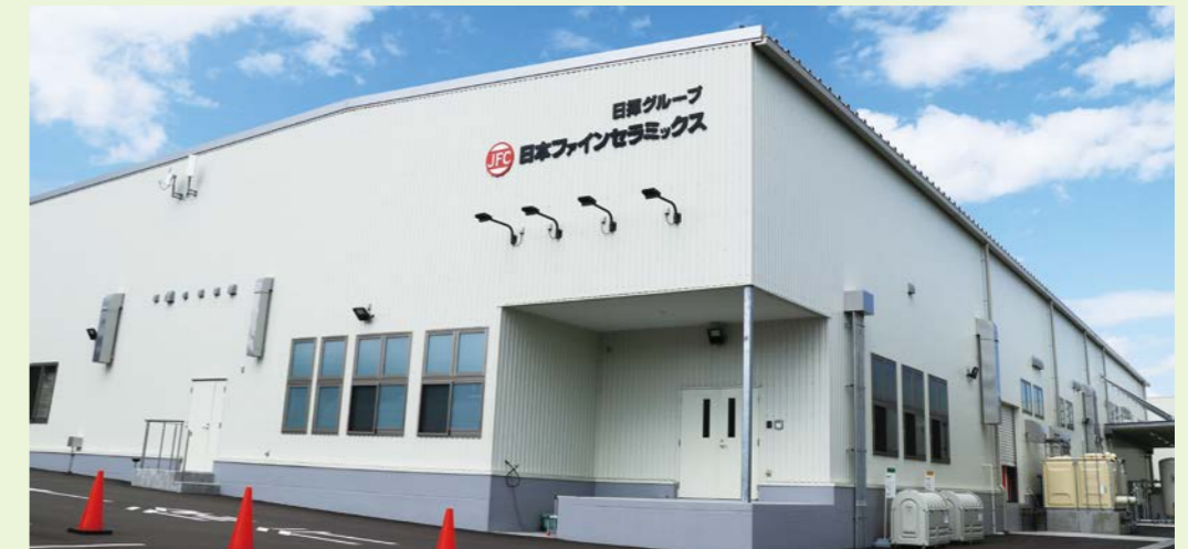
窒化ケイ素新工場(SN棟) 2021年1月稼働開始
