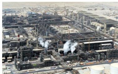
カタール・シェルGTL社向けGTL (Gas to Liquids)プラント 完工:2012年
