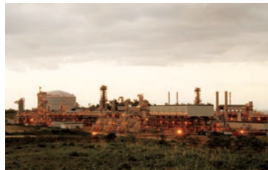
BPベラウ社向けLNGプラント 完工:2009年
