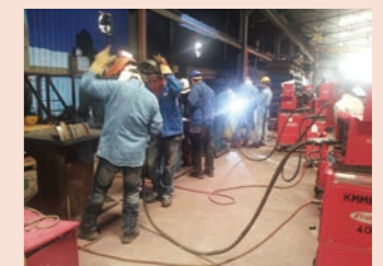
溶接向けトレーニングの様子
