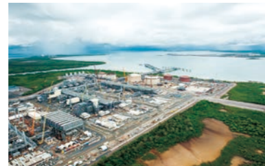
インベックス社向けLNGプラント 生産開始:2018年
