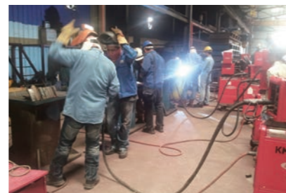
溶接工向けトレーニングの様子
