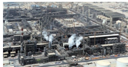
カタール・シェルGTL社向けGTL(Gas to Liquids)プラント 完工:2012年
