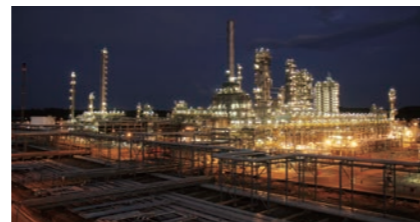
ベトロベトナム社向け石油精製プラント 完工:2009年
