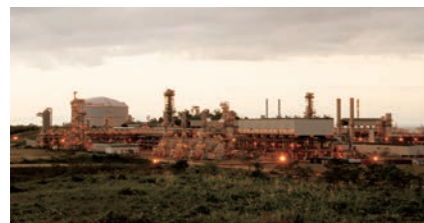
BPベラウ社向けLNGプラント 完工:2009年
