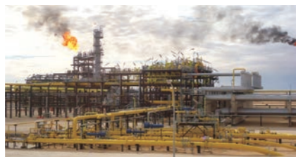
ソナトラク社向けガス集積・分離プラント 完工:2013年
