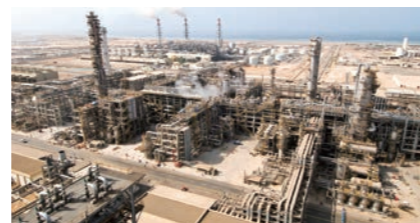
ベトロ・ラービグ社向け(サウジアラムコ社と住友化学社の合弁)石油精製・石油化学統合コンプレックス 完工:2008年
