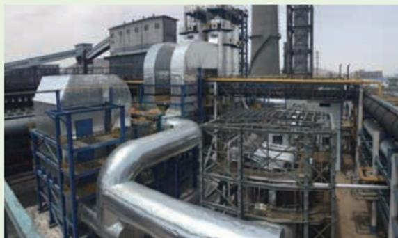
中低温排ガス向け乾式脱硫・脱硝システムを設置したコークス製造プラント(中国内モンゴル自治区)
