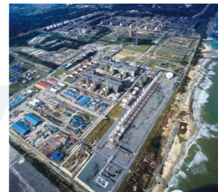
マレーシア向けLNGプラント
