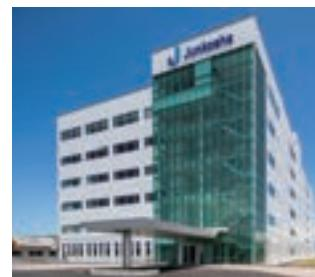
本物件は、同社のフッ素ポリマー製品の生産能力増強を目的として建設され、震災時対策としての免震構造を備えた工場であります。空調設備としては空冷モジュールチラーおよび外調機+空調機方式を採用し、省エネ運転が可能なシステムとなっております。また各製造室では外気処理量、局所排気量、各ユーティリティーを自由に配置可能とし、利便性向上を図っております。
