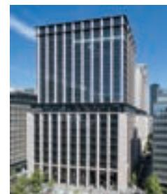
本物件は、大阪市のメインストリートである御堂筋に新築された事務所ビルです。空調方式にターボ冷凍機・空冷ヒートポンプチャラー・吸収式冷温水機を採用し、電気・ガス両方式を用いることで、インフラ断絶等の有事のリスク分散を図っています。また、今後発生が予想される東南海・南海地震等による津波を想定し、機械室を中間階に設けるなど、信頼性・安全性の高い設備となっております。
