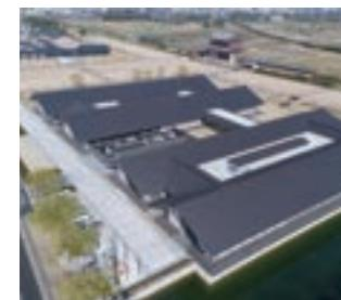
本物件は、平城宮跡歴史公園内に建設された展示施設であります。館内では映像プログラムや復元模型を展示しており、平城宮跡から出土された文化財の保存もしています。設備の特色としては、床吹出空調を併用した冷暖房床放射設備を採用し来館者の快適性を確保しております。またデシカント空調機および潜熱顕熱分離空調機による精緻な湿度制御を行うなど、文化財保護に配慮した設備となっております。
