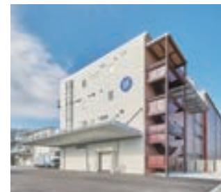
本物件は、医薬品原材料の保管量確保と効率的な仕分けを行うために新設された立体自動倉庫施設と試験施設で構成されます。自動倉庫は医薬品GMPに準拠した施設となっており、多点温度記録計や当社が開発した中央監視システム(TEC BEAMS®)を導入することで倉庫内環境を監視、制御しています。試験施設ではドラフトチャンパーの大量排気に対応するため、外気に温調設備を設けることで試験環境の維持、向上を図っています。
