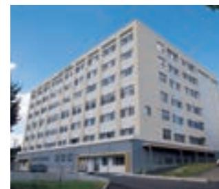
本物件は、既設病棟の老朽化に伴い、約50年ぶりに全面建替された新病棟であり、慢性重症疾患に対する医療・介護・福祉の充実と地域医療の実践に取り組んでいます。空調方式は主に空冷パッケージエアコンを主体とした個別空調を採用しております。建物は東日本大震災の経験から免震構造を採用しております。また衛生設備として、給湯用ヒーターや貯湯槽、消火ポンプ類を設置し、隣接する既存病棟にも供給しております。
