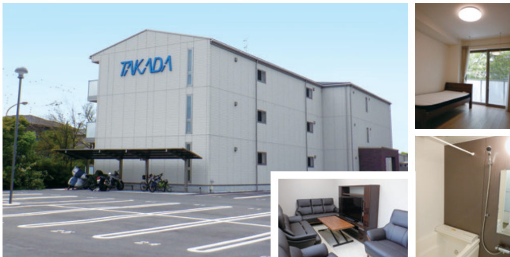
新設した富津寮2号館
