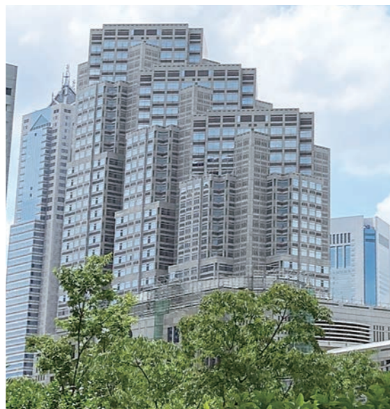
東京都庁舎の改修工事
