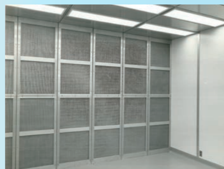
高砂層流式クリーンルーム
