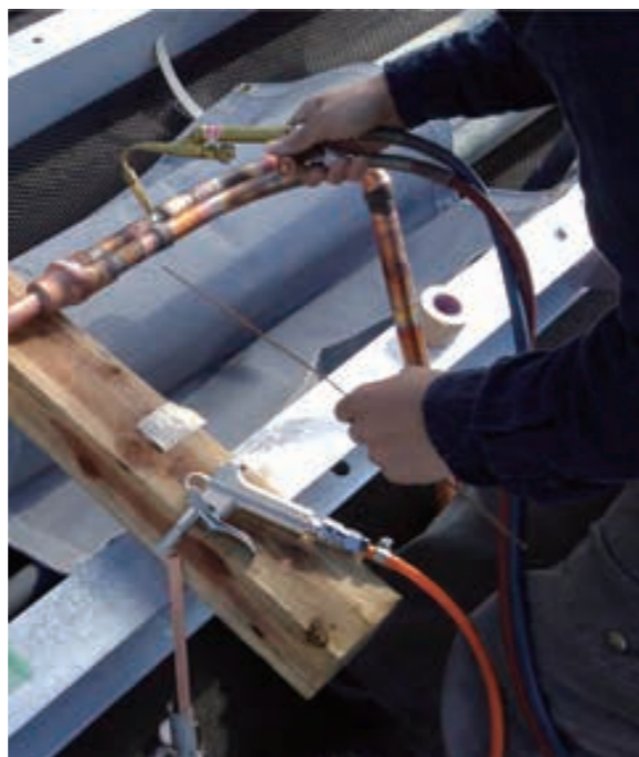
エルブレイズ工法施工状況
