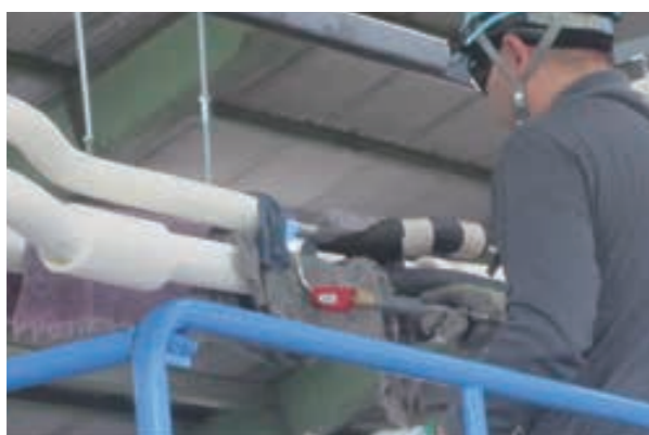
アルミ管のろう付施工状況
