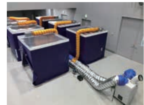
「災害時避難所用コロナ対策空調換気ブース」全景
