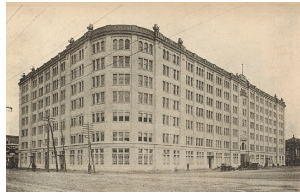
1918 東京海上ビル 日本初の近代的なオフィスビル
