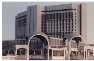
1981 ニューダイ病院(アラブ首長国連邦)空調・給排水衛生・電気・医療ガス設備工事
