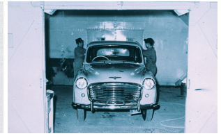
1953 いすゞ自動車大森工場 スプレーブース
