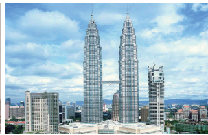
1994 ペトロナスツインタワー(マレーシア)
