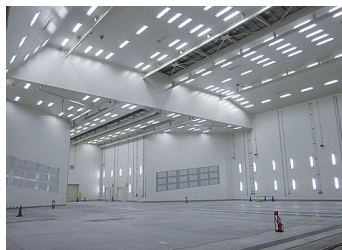
塗装工場Aブース内部
