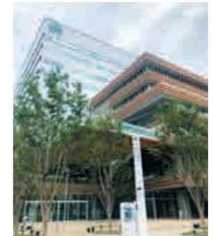
千葉市役所 新庁舎 【空調設備工事】
