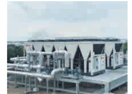
ベトナム K社チラー熱源改修工事
