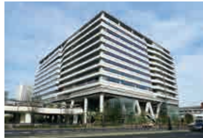
メブクス豊洲 【空調・給排水衛生設備工事】
