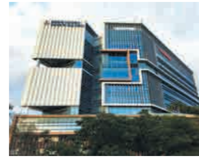
シンガポール COH Service Building新築工事
