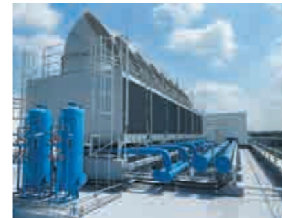
タイランド SIIX新築工事
