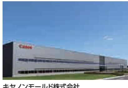
キヤノンモールド株式会社 本社・友部事業所 (茨城県) 【電気設備工事】
