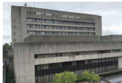
津市本庁舎大規模改修 【電気・空調・給排水衛生設備工事】
