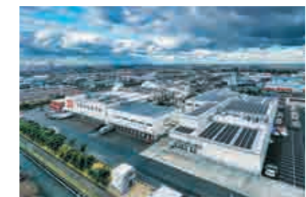
一正蒲鉾株式会社本社第二工場 (新潟県) 【空調・給排水衛生設備工事】
