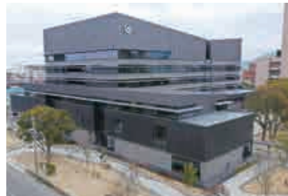
八代市新庁舎 【空調・給排水衛生設備工事】
