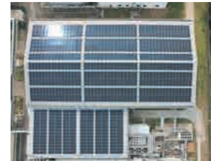
タイランド T社太陽光電池設置工事
