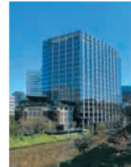
九段会館テラス 【空調設備工事】
