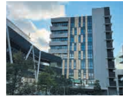
シンガポール MAH新築工事
