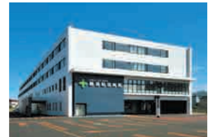
静和記念病院 (北海道) 【空調・給排水衛生設備工事】
