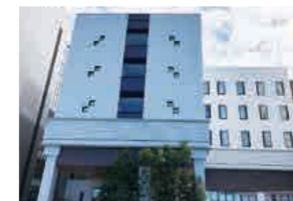
国立長寿医療研究センター (愛知県) 【電気設備工事】
