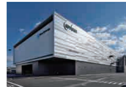
株式会社GSユアサ 新工場 (京都府) 【給排水衛生設備工事】
