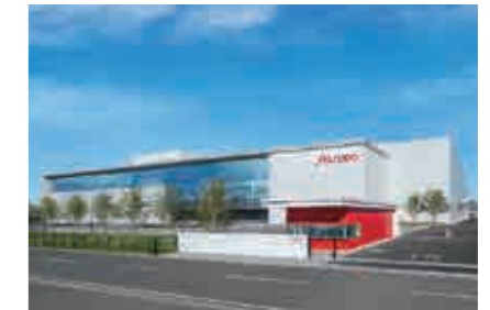
資生堂久留米工場生産設備 【給排水衛生設備工事】
