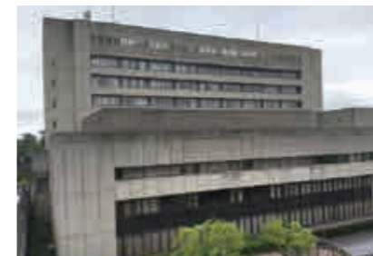
津市本庁舎大規模改修 【電気・空調・給排水衛生設備工事】
