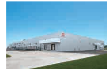
日本ハム北海道ファクトリー株式会社新工場 【空調・給排水衛生設備工事】
