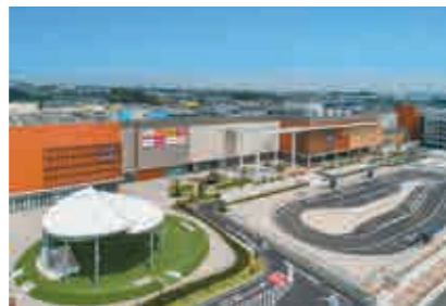
ららぽーと愛知東郷 【電気設備工事】
