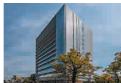
西宮市第二庁舎 【空調・給排水衛生設備工事】
