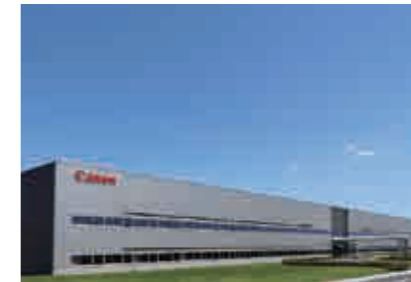
キャノンモールド新工場 (茨城県) 【電気設備工事】
