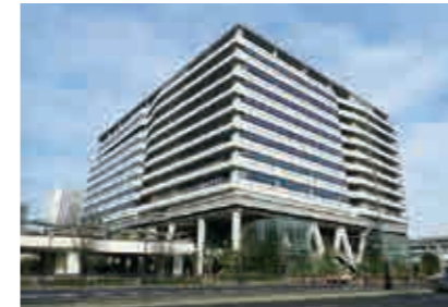
メプクス豊洲 【空調・給排水衛生設備工事】
