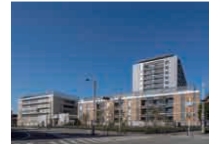
兵庫県立はりま姫路総合医療センター 【給排水衛生設備工事】
