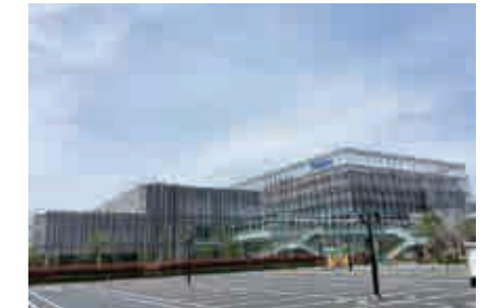
Kurita Innovation Hub (東京都) 【電気設備工事】
