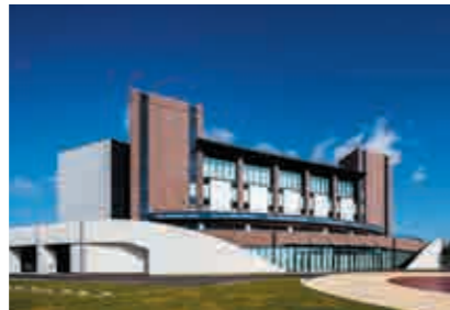
沖縄アリーナ 【空調設備工事】
