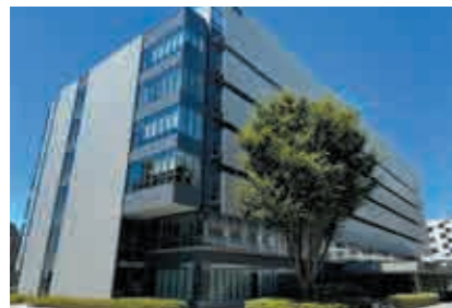
北里大学医療衛生学部A1号館 【電気・空調・給排水衛生設備工事】
