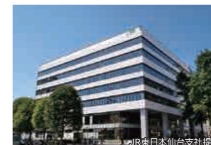
JR東日本仙台支社 【空調設備工事】
