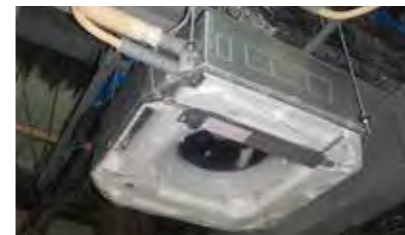
天井面に設置した室内機の内部を、施工中に舞い上がる塵埃や塩害から保護
