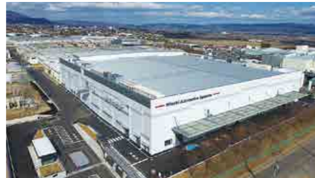
日立オートモティブシステムズ 福島事業所・研究開発棟及び第5工場 【空調・給排水衛生設備工事】
