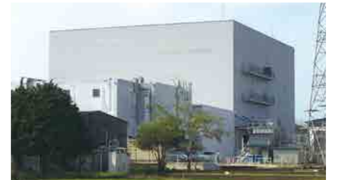
東海カプセル株式会社 本社工場 【空調・給排水衛生設備工事】
