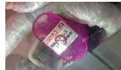
天井内に納める設備のメンテナンススペースを工事期間中に可視化して確保
