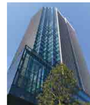
コモレ四谷 【空調設備工事】
