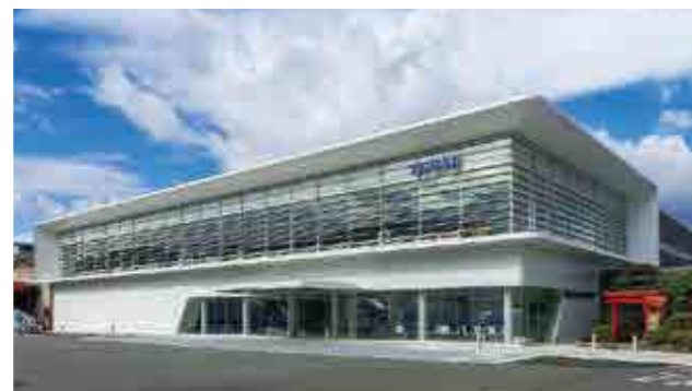
テラル株式会社 新社屋(ZEBオフィス) 【空調・給排水衛生設備工事】
