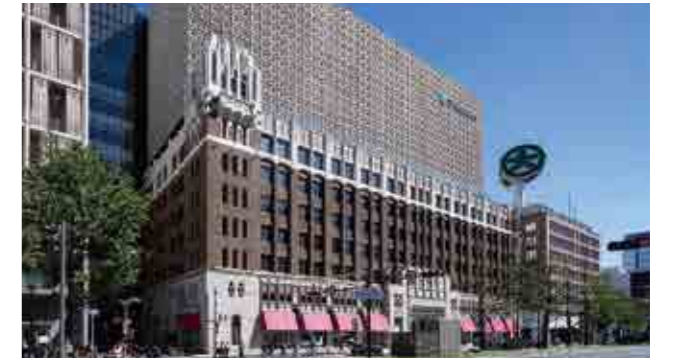
大丸心斎橋店 本館 【電気設備工事】
