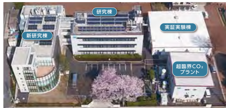
技術研究所全景 (埼玉県入間郡三芳町)
