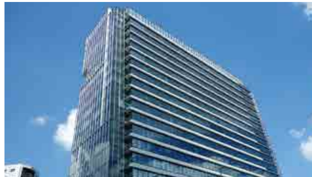
渋谷ソラスタ 【空調・給排水衛生設備工事】
