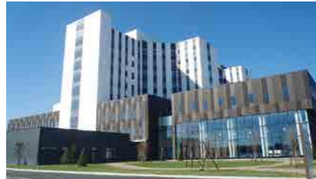
帯広厚生病院 【給排水衛生設備工事】
