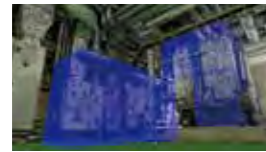
設備BIMモデルと合成し納まり検討
