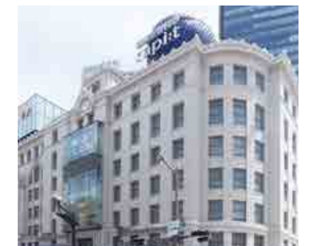
南海電気鉄道株式会社 南海ターミナルビル 【電気設備工事】
