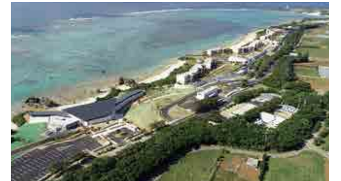
星のや沖縄 【空調・給排水衛生設備工事】
