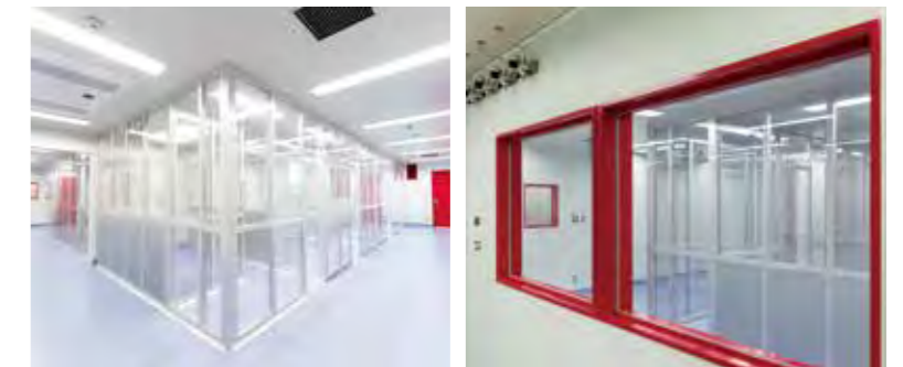
施工事例(クオリプス株式会社様 2020年7月竣工)
