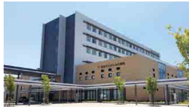
高松市立みんなの病院 【空調・給排水衛生設備工事】
