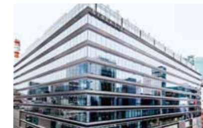
GINZA SIX(ギンザ シックス) 【電気設備工事】
