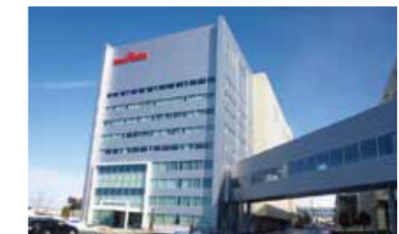
富山村田製作所D棟 【空調・給排水衛生設備工事】
