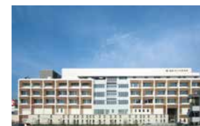
倉敷市立児島市民病院 【空調・給排水衛生設備工事】
