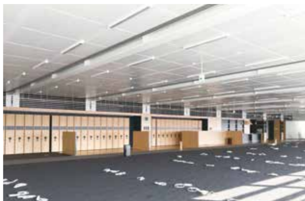
天井輻射パネルによる室内
