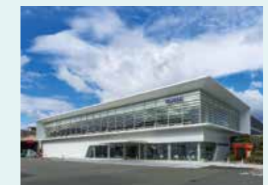
施工事例③ テラル株式会社 ZEB新社屋
