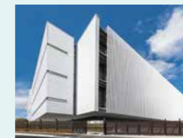
施工事例② netXDC 三田第2センター
