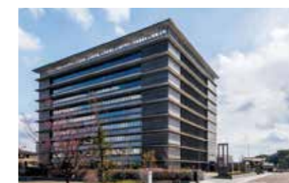
和歌山地方合同庁舎 【空調・給排水衛生設備工事】
