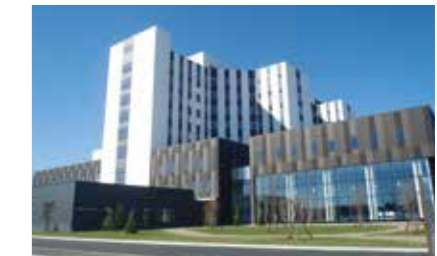
帯広厚生病院 【給排水衛生設備工事】
