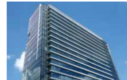
渋谷ソラスタ 【空調・給排水衛生設備工事】
