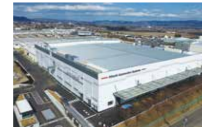
日立オートモティブシステムズ 福島事業所・研究開発棟及び第5工場 【空調・給排水衛生設備工事】
