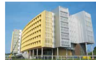
九州大学伊都キャンパス農学系総合研究棟 【空調設備工事】
