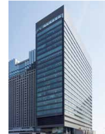
なんばスカイオ 【電気・空調・給排水衛生設備工事】
