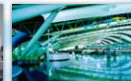
1994年/関西国際空港管制塔旅客ターミナルビル[大阪]
