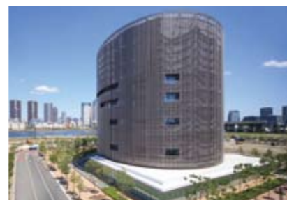
豊洲スマートエネルギーセンター 【電気・空調設備工事】
