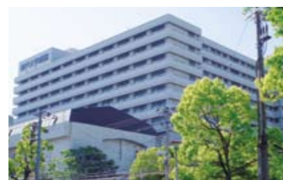
神戸大学医学部附属病院低侵襲総合診療棟 【電気・空調・給排水衛生設備工事】
