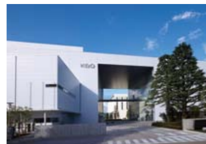
花王小田原CP-R3プロジェクト 【空調・給排水衛生設備工事】
