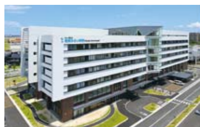
医療法人相生会福岡みらい病院 【空調・給排水衛生設備工事】
