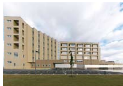
JA新潟厚生連小千谷総合病院 【空調・給排水衛生設備工事】
