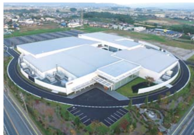
佐久シチズン時計工場【空調・給排水衛生設備工事】
