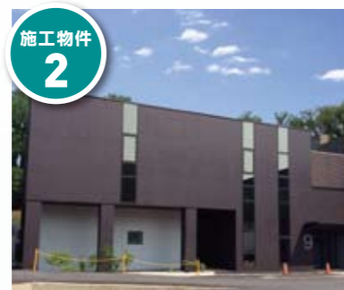
日本歯科大学 新潟 9号館研究棟
