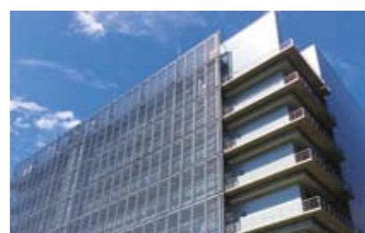
日亜化学工業新K-1棟【空調・給排水衛生設備工事】
