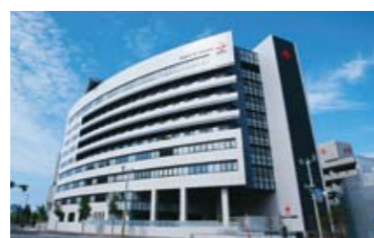
広島赤十字・原爆病院【空調設備工事】
