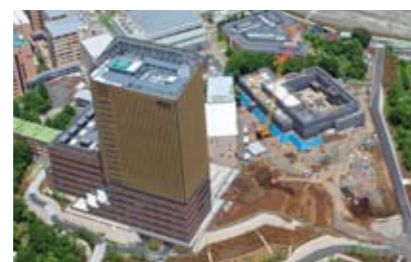
帝京大学八王子新校舎1期 【空調設備工事】
