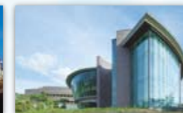
2010年/沖縄科学技術大学院大学研究棟センター棟[沖縄]
