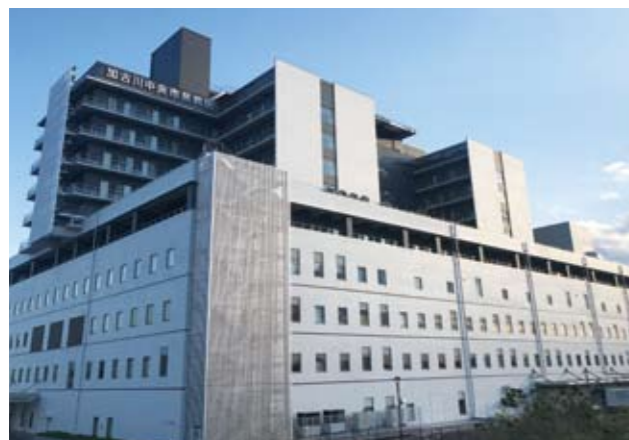
加古川中央市民病院【空調設備工事】
