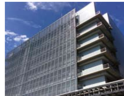
日亜化学工業新K-1棟【空調・給排水衛生設備工事】
