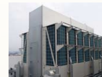
空冷チラー消音器設置状況
