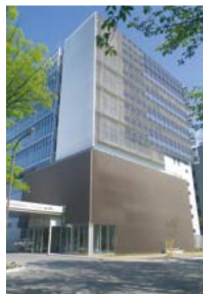
信州大学国際科学イノベーションセンター【空調・給排水衛生設備工事】
