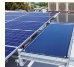
太陽光発電パネル/太陽光集熱器
