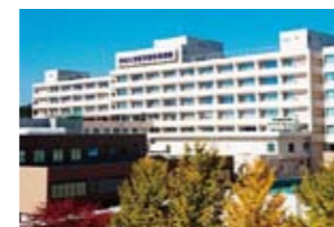
秋田大学医学部附属病院【空調設備リニューアル工事】
