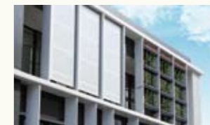
膜ルーバー/緑化壁
