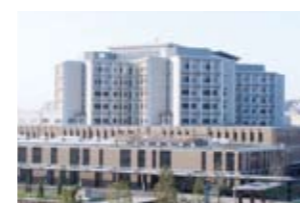
鹿児島市立病院【給排水衛生設備工事】
