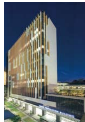
シンガポール国立大学 薬学棟【電気設備工事】
