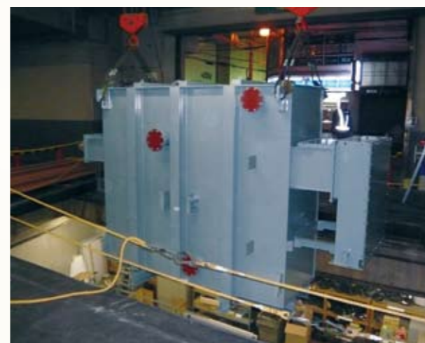
No.3特高トランス(搬入状況)
