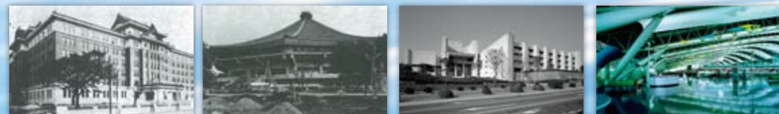
1938年/愛知県庁舎[愛知] 1964年/日本武道館[東京] 1974年/最高裁判所庁舎[東京] 1994年/関西国際空港管制塔旅客ターミナルビル[大阪]
