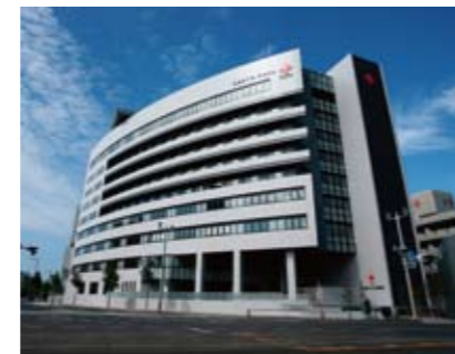
広島赤十字・原爆病院【空調設備工事】
