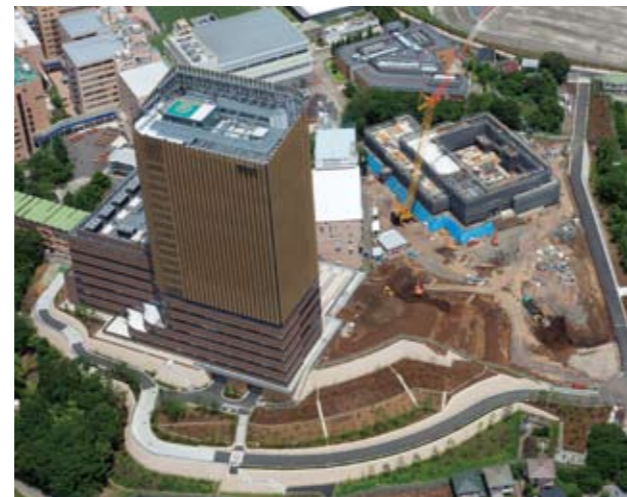
帝京大学八王子新校舎1期【空調設備工事】
