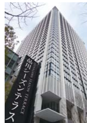
品川シーズンテラス【空調設備工事】
