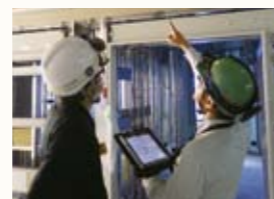
施工状況の確認
