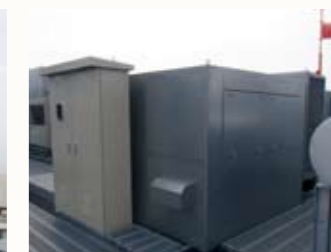
ファン消音器設置状況
