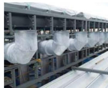
外壁貫通ダクト、配管先行施工
