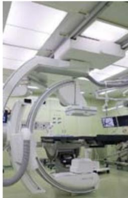
調光式LED照明内蔵型HEPAフィルタユニットを採用したハイブリッド手術室
