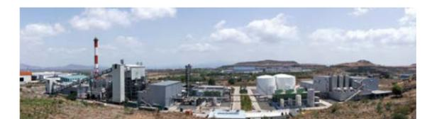
8月に稼働したイースト工場。排水を工場敷地内で再利用して敷地外に排水しないゼロ排水(ZLD: Zero Liquid Discharge)システムを導入している(OY インド)
