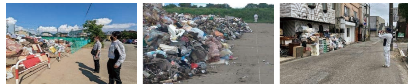
街中の仮置場の災害廃棄物残量の把握 広域仮置場(旧空港跡地)への運搬量の把握 街中の道路上(脇)に残されている災害廃棄物の場所と内容の把握
