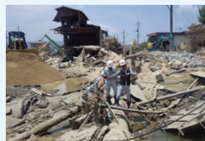
「安全・安心」を創り出すための基礎となる災害現場の調査 (2018年 西日本豪雨被災現場調査)
