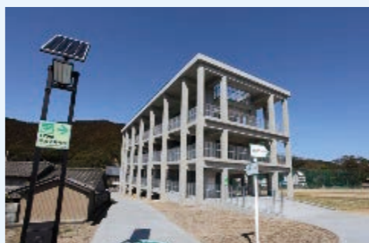
南海トラフ地震に備えた津波避難タワーの新設(徳島県)地元自主防災会と協議しながら、ハード対策とソフト対策の両面を実施
