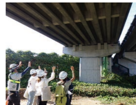
橋梁点検の体験学習のための大学生向け出前講座 橋梁の下部工に生じたひびわれ計測、打音検査、損傷評価、全方向衝突回避機能を備える最新の小型ドローンJ21による橋梁上部工の点検、非破壊検査機器を使った詳細調査等について体験
