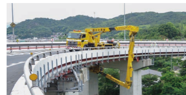
橋梁点検作業
