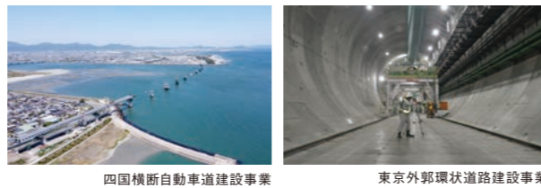
四国横断自動車道建設事業
