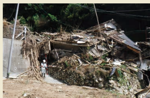
家屋倒壊現場
