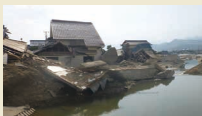
破堤による家屋の被災状況
