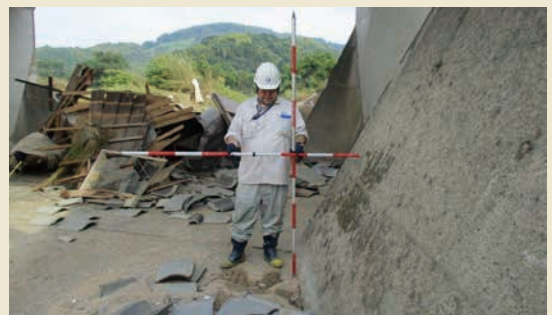
復旧への測量作業
