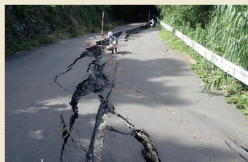
道路の復旧に向けた測量作業
