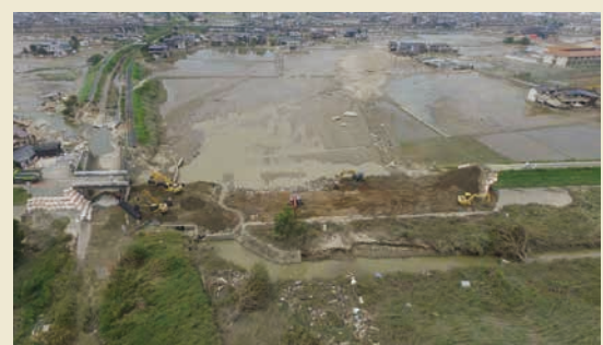
堤防復旧作業風景
