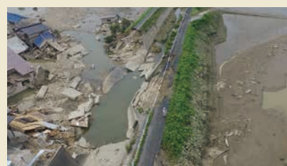
小田川破堤状況
